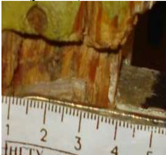
Рис. 22. Внешний вид повреждений на обвязке двери
